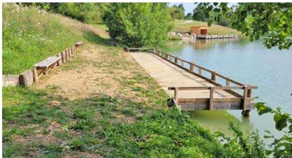
Afin d'améliorer l'accès à l'eau pour les embarcations, la Fédération a créé sur **le plan d'eau de BOUILLAC à Gariès** une mise à l'eau confortable de 4.5 mètres de large et une grande aire de retournement de 16 mètres de diamètre.
